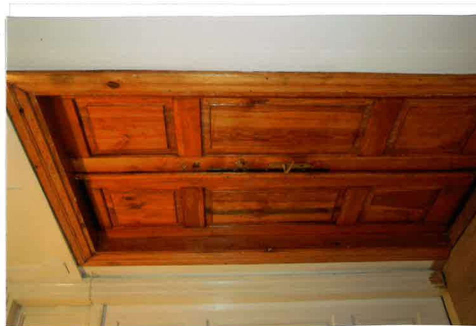
Fot. 6. Drzwi z klatki schodowej na korytarz I piętra, 2020.
