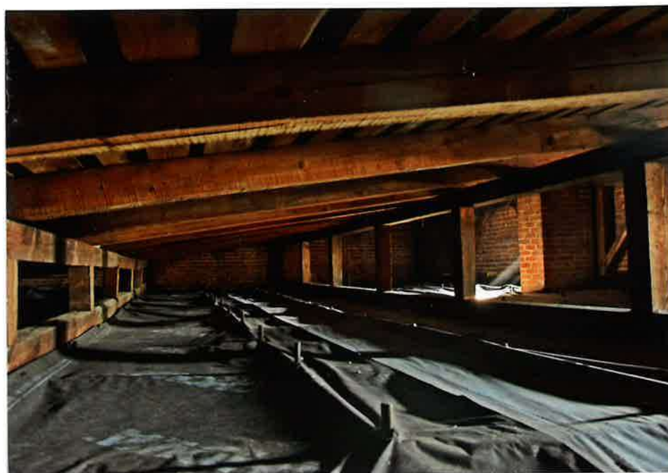
Fot. 13. Więźba dachowa, 2020.
